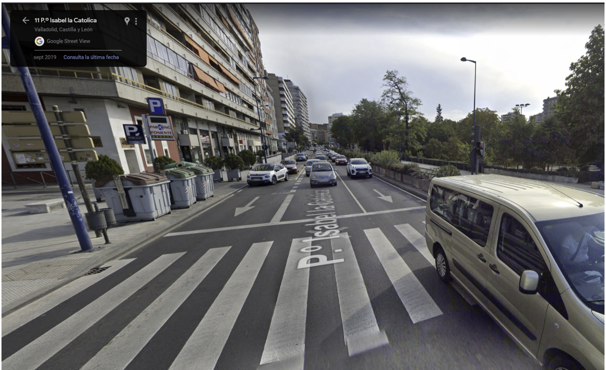
Figura 2. Carril reservado bus-taxi ocupado por vehículos privados en el cruce con la Plaza Poniente en septiembre de 2019. Fuente: Google Street View.
